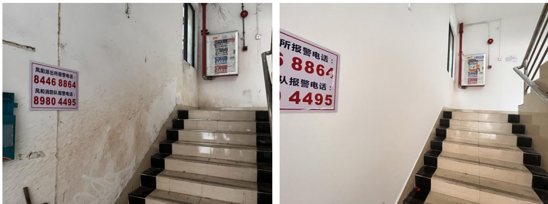
楼梯粉刷前后
